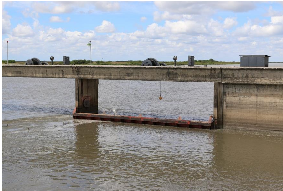
Figura 13 – Corpo da Barragem do Canal São Gonçalo, com destaque para uma de suas 18 comportas de margem a margem.
