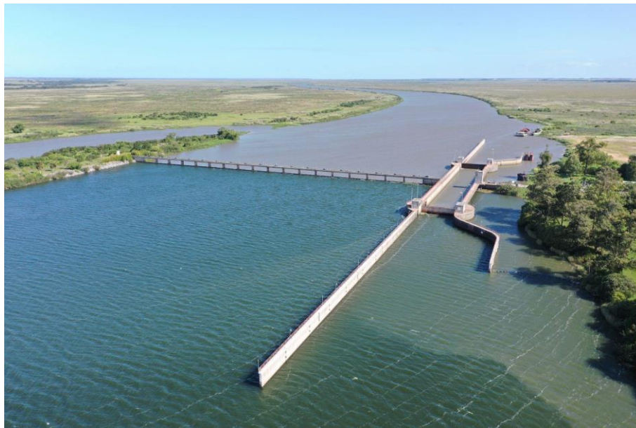
Figura 12 – Barragem do Canal São Gonçalo e sua eclusa para navegação, com destaque para ocorrência de intrusão salina (16 de março de 2022).
