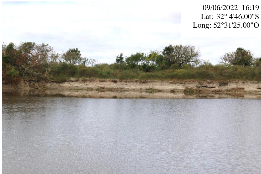
Figura 32 - Estado de degradação das margens do Canal São Gonçalo, em locais sem cobertura de vegetação.
