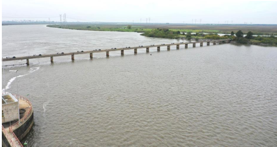
Figura 34 - Vista do eixo principal da Barragem do Canal São Gonçalo, apresentando as 18 comportas que impedem a intrusão salina da porção sul do canal.
