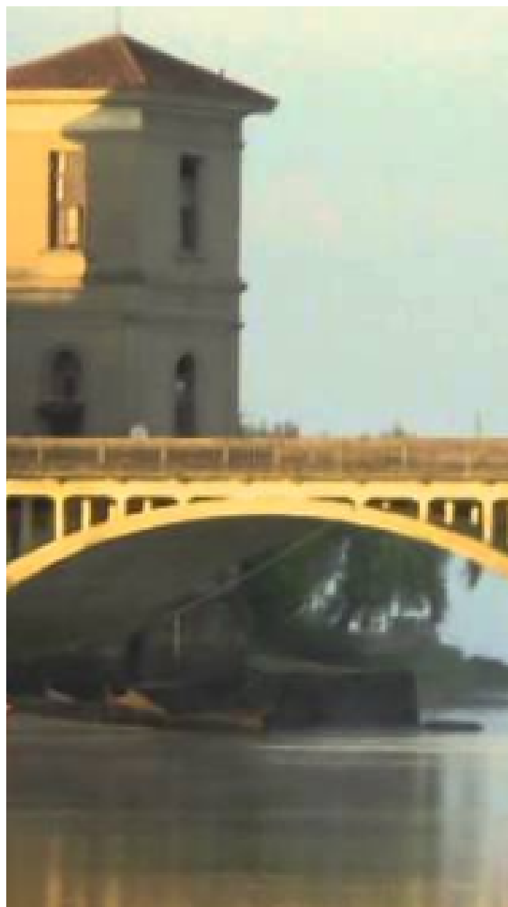
Ponte sob o Rio Jaguarão.
