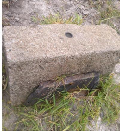
Figura 93: Obstrução de tomada d'água, P88.
