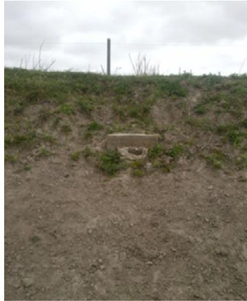
**Figura 96:** Estrutura de tomada d'água em deterioração, P98.
